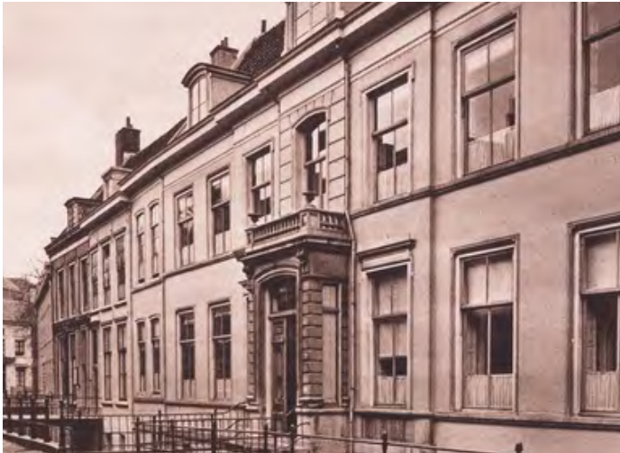
Gebouw van de CCRB aan de Kromme Nieuwegracht in Utrecht 1924-1957
